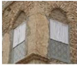
البناء بالحجر والأجر المحروق وشباك خشبي مع استخدام الستارة البيضاء للخصوصية
