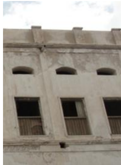
نموذج للشباك والمنور " الفتحة" العلوية لحركة الهواء
