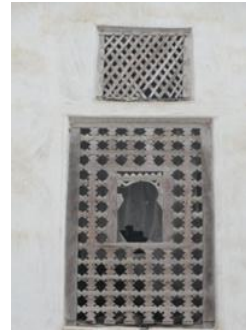
فتحات خشبية لتبرير الهواء مع فتحة علوية لخروج الهواء الحار
