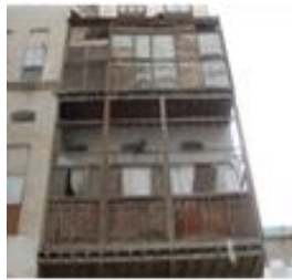
شرفة بشكل مشربية مستمرة بأدوار المبنى
