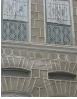
الواجهة من الحجر والعقد الموتور مع شبابيك خشبية وفتحات لتبرير الهواء
