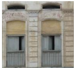
البناء بالطريقة التقليدية مع مداميك الحجر البارزة
