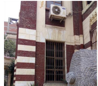
شكل (33) يوضح استخدام أنظمة تكييف غير المتوافقة بينيا المصدر : الباحثة
