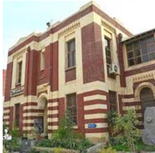
شكل (11) يوضح الواجهة الخارجية للمبنى المصدر: الباحثة 2020-2-22
