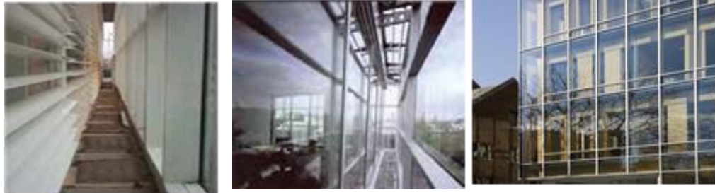
شكل (٣): يوضح صورة نموذج لواجهات الهياكل الصندوقية [١١]. شكل (٤): يوضح لقطة داخلية للفراغ الهوائي بمبنى فيكتوريا بألمانيا واستخدم نظام الواجهات المزدوجة متعددة الطوابق [١١]. شكل (٥): يوضح صورة لوسائل التظليل بين طبقات ألواح الزجاج بواجهات مبنى المركز الرئيسي لشركة GSW، فيما عدا الواجهة الغربية [١١].
