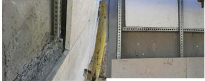
شكل (١): يوضح استخدام مواد عازلة للحرارة داخل الحوائط الخارجية، وتثبيت مادة البوليسترين خلف الرخام في الحوائط الخارجية [١١].
