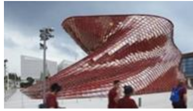
شكل (٢٠): يوضح تغطيته أغلفة مبني جناح انكو معرض إكسبو العالمي في إيطاليا بالسيراميك وتثبيته ميكانيكيا [٣١].
