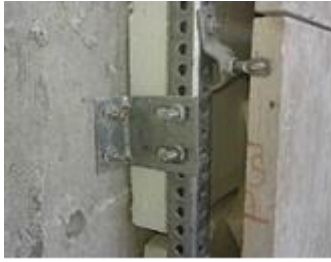
شكل (١): يوضح استخدام مواد عازلة للحرارة داخل الحوائط الخارجية، وتثبيت مادة البوليسترين خلف الرخام في الحوائط الخارجية [١١].
