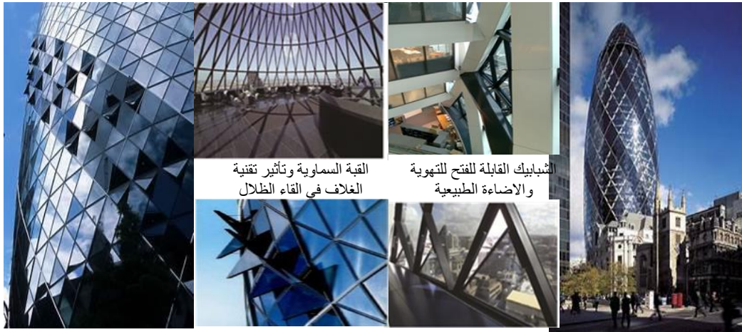
منظر عام للبرج شكل (٢٩): منظر عام لبرج Swiss re وشكل الغلاف الخارجي الزجاجي والشبابيك القابلة للفتح [٤٩، ٨]. الشبابيك القابلة للفتح للتهوية والإضاءة الطبيعية الشبابيك القابلة للفتح للتهوية والإضاءة الطبيعية القبة السماوية وتأثير تقنية الغلاف في القاء الظلال الشبابيك القابلة للفتح للتهوية والإضاءة الطبيعية
