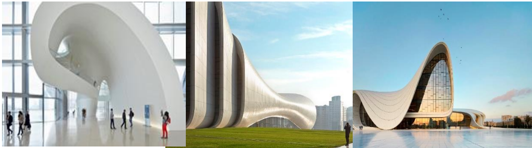
شكل (٢٤): يوضح استخدام الخرسانة المسلحة بالألياف الزجاجية بواجهات مركز حيدر عليلف والفراغات الداخلية [٣٧].
