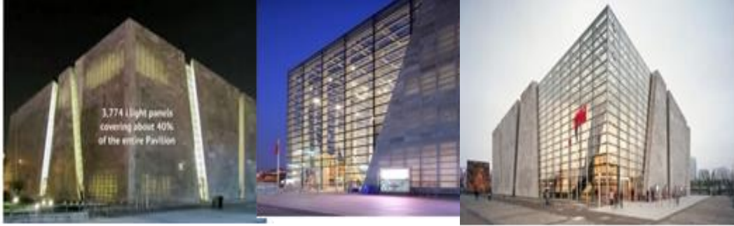
شكل (٢٣): يوضح استخدام الخرسانة الشفافة في واجهات الجناح الإيطالي في شنغهاي [٣٠،٣٤].
