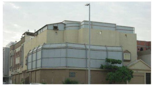
أ- استخدام ألواح صاج مموجة أعلى السطح السور
