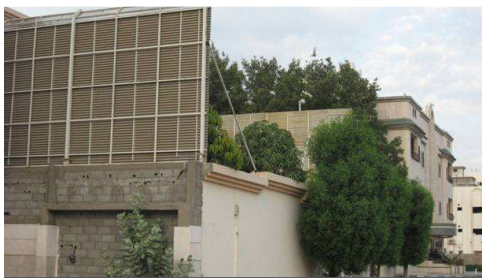
ب- استخدام ألواح صاج مموجة أعلى بارتفاع المسكن
