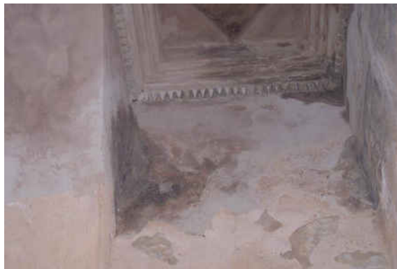
الشكل رقم 6ب، ج. قصر الخرانة، أسقف فراغات في الطابق الأول تعاني من مظاهر تلف متعددة مثل نفاذ الرطوبة ووجود ظاهرة تزه الأملح والتعفن في بعض الأجزاء داخل القصر.
