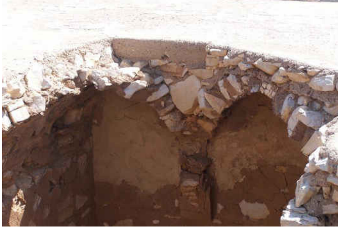
شكل رقم 6 أ. قصر الخرانة، الخلطة الخرسانية القوية والسميكة على سطح القصر وأسفل منها المواد الأصلية الضعيفة المتردية.
