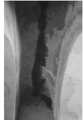
الشكل رقم 6ب، ج. قصر الخرانة، أسقف فراغات في الطابق الأول تعاني من مظاهر تلف متعددة مثل نفاذ الرطوبة ووجود ظاهرة تزه الأملح والتعفن في بعض الأجزاء داخل القصر.
