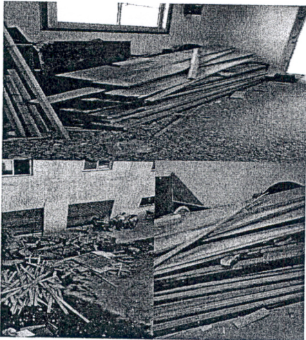
صورة (١٠، ١١، ١٢) للأخشاب والقطع القديمة المعدة للتجهيز قبل عمل تصميمات تتناسب مع سمك وأطوال الأخشاب لتنفيذ ما يتناسب مع مقاييس الخشب المتاح
