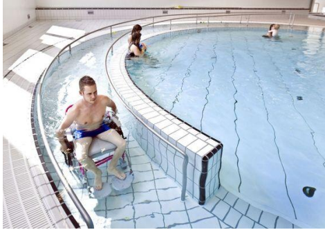
شكل (8) تزويد حمامات السباحة بمنحدر ومصاطب جلوس مغمورة بالماء ليجلس عليها المعاق أو المسن - مركز فاندالايغمونت لإعادة التأهيل.
