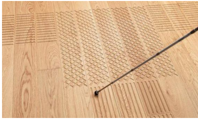
شكل (9) حفر الأرضيات بأنماط pattern مختلفة واستخدامها كلفة تحذيرية حيث يدل الحفر المستقيم على اتجاه الطريق والنمط المربع على وجود مفترق طرق.
