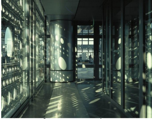
شكل (1) يوضح تأثير الكاسرات الشمسية على الفراغات الداخلية مما يسبب الانزعاج البصري.
