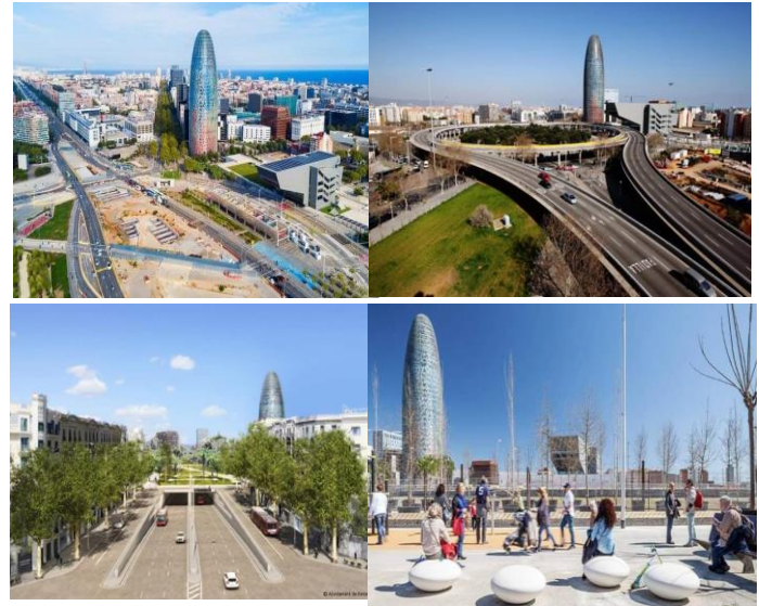
شكل (16) يوضح إزالة كباري السيارات بميدان جلوريا برشلونة و إستبدالهم بأنفاق تحت الأرض لتترك المساحات السطحية للأنشطة و الحياة الإجتماعية [22]، [23]
