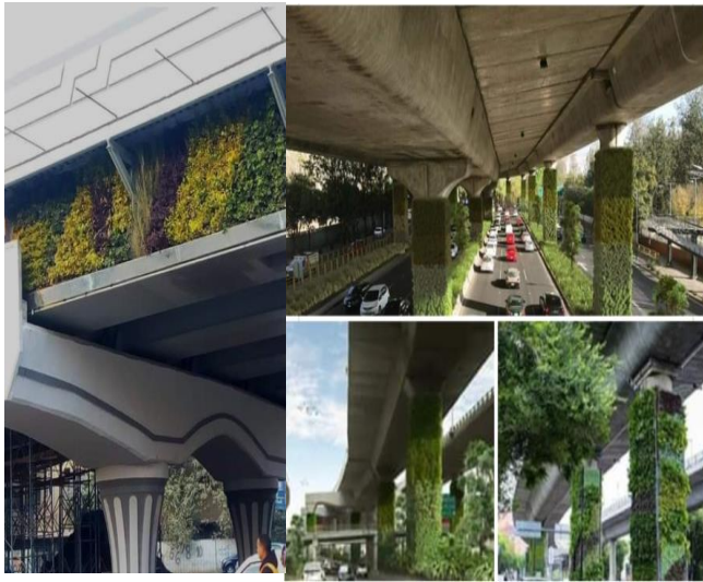
شكل (17) يوضح المعالجات البيئية و الجمالية لكباري السيارات المقترحة من اليمين و ما تم تنفيذه بإحدى الكبارى الجديدة من اليسار عن طريق تزويدها بستانر رأسية من النباتات. [22]
