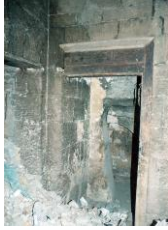
(١٠) لوحة تبين الفتحة التي تقضى إلى بيارة الصهريج بالضلع الجنوبي الغربي
