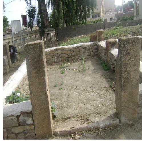
الصور رقم (٨) (٩) الغرف الشرقية بحمامات تيقزيرت
