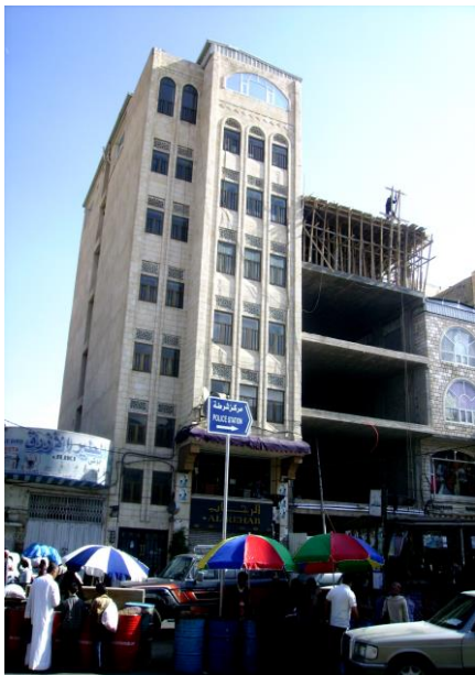
شكل(11) إعادة استثمار الأرض- مباني أعيد بنائها، ومبان قيد الإنشاء ومباني منتظرة، ازدحام بالمباني والناس- شارع جمال
