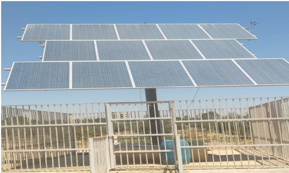
صورة (١١) محطة طاقة شمسية جامعة جنوب الوادي طاقة ٣٥٠٠ وات ٢٠١٩/٣/١٩..
