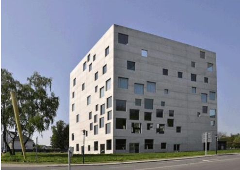
شكل رقم (19) توضح عدم الترابط بين الفتحات وانتظامها في الواجهة المصدر:
