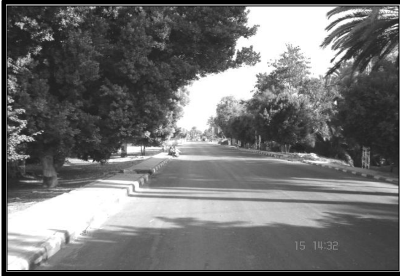
صورة (2) عدم وجود جزيرة في المنتصف لوصلة ( أدفو/ إسنا): من أحد أسباب وقوع الحوادث.
