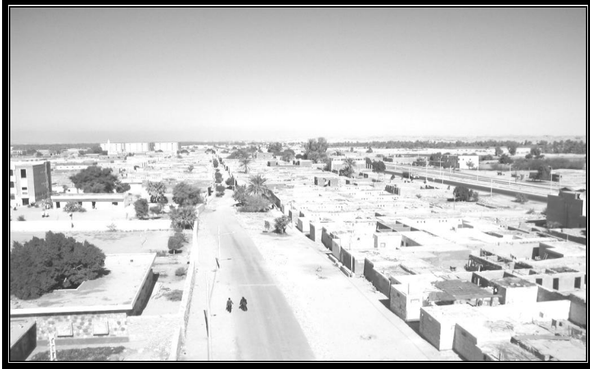
صورة (3) ضيق الشارع الرئيسي بمدينة كلابشة وسوء الصرف، وعدم وجود جزيرة في المنتصف من أهم أسباب الحوادث داخل المدن .
