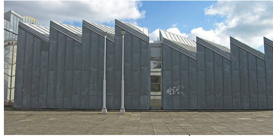
صورة (5):متحف أبتيبيرج للمعماري هانز هولين * ميونخ عام 1982 م، ألمانيا لما بعد الحداثة في ألمانيا.ويظهر في الشكل التعددية والتكرار في التصميمية في ميول السقف والتي تعبر عن سمات هذا النسق المعماري.
