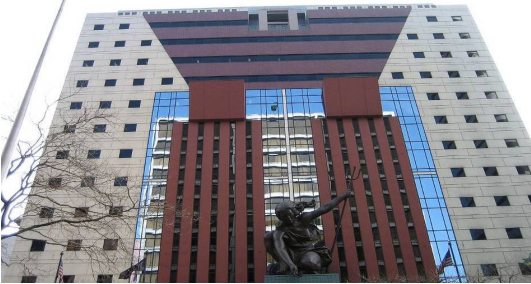
صورة (6): مبنى الخدمة العامة بورتلاند "Portland Public Service Building" 1982 لمبايكل جريفز* Michael Graves " أول بناء لما بعد الحداثة الكبرى ولقد وصفت تصميمه بمثابة رفض للمبادئ الحداثة التي أنشئت في أوائل القرن 20 -8- التراكم الصوري في عمارة ما بعد الحداثة: إتصفت هذه المرحلة من عمر العمارة بإغراق الواجهات برموز الماضي كمشاهدة لإعادة الترابط مع الموروث؛ صورة (7) توضح كيفية الإقتباس واللتصق لرموز من فنون حضارات كلاسيكية سابقة .
