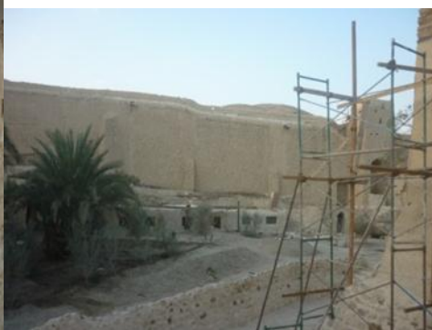
Fig. (5): The wall
