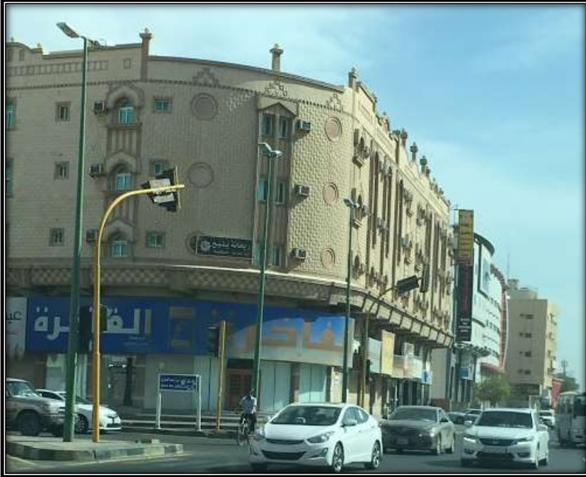
صورة (٢): المباني في مدينة ينبع البحر. المصدر: الدراسة الميدانية للمدينة بتاريخ ١٧ سبتمبر ٢٠٢٠.
