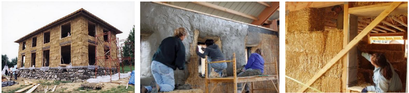
شكل " 11 " استخدام بالات القش في عملية البناء وخصائصها المميزة كعازل صوتي مقاوم للنيران ، ومقاومتها للرطوبة بعد الانتهاء من عمليات النهج والتشطيب لها بالإضافة إلى قدرتها على تنقية الهواء الداخلي للفراغات
