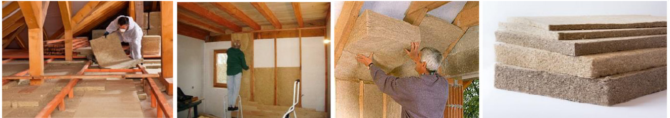
شكل ” 22 ” استخدام ألياف نبات القنب كبلاطات للعزل الحراري والصوتي في الفراغات الداخلية ” أسقف – حوائط – أرضيات ”
