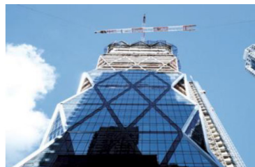
صورة رقم (21) , (22) توضح الواجهات المزدوجة للمبنى أثناء التنفيذ (على اليمين) واختراق الإضاءة الطبيعية للواجهات الزجاجية للمبنى (على اليسار) .
