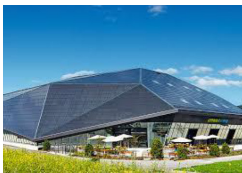
صورة رقم (10) ، (11) توضح غلاف مبنى Umwelt Arena ذو السقف البلورى من وحدات PV.
