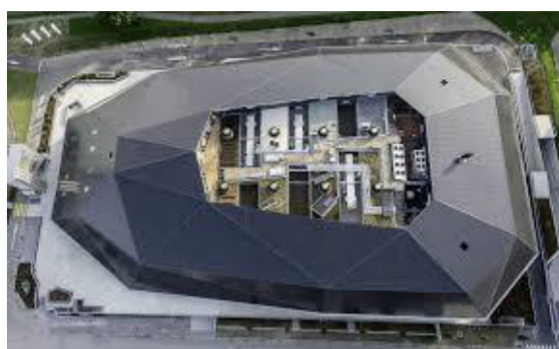
صورة رقم (10) ، (11) توضح غلاف مبنى Umwelt Arena ذو السقف البلورى من وحدات PV.
