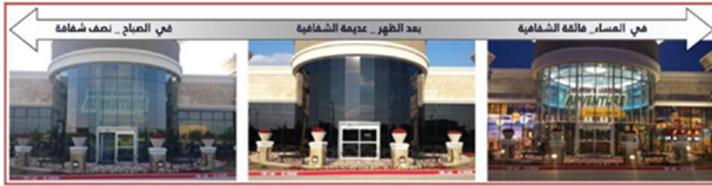
صورة رقم (8) يوضح التحول في زجاج الثرموكروميك بسبب حرارة أشعة الشمس .
