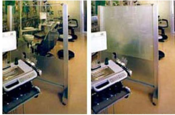
صورة رقم (9) وشكل رقم (7) يوضح النوافذ ذات تقنية البلورات السائلة وكيفية تحولها من الشفافية إلى الإعتام فى حالة عدم مرور تيار كهربى.
