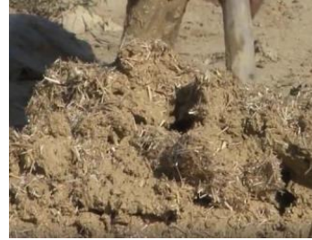
صورة (١٣ و١٤ و١٥) خلط الطمي بالقش (حشا الارض اى الزرع rammed earth او - Cop لعمل مونة الملاط الطيني واستخدام الطفلة الاسوانى فى عمل الطوب الطفى اللين المنتظم المستوى الواجه.
