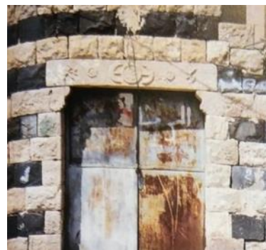
صورة (٧) بلدة Irbid بالاردن - البناء بحجر Ashlar masonry يتم تقطيعه بالمنشار او الازميل وهو من ٤ او ٥ او ٦ اوجه - البناء من طبقات من حجر البازلت basalt والحجر الجبرى lime وتم نقش السطح peripheral chiseling.
