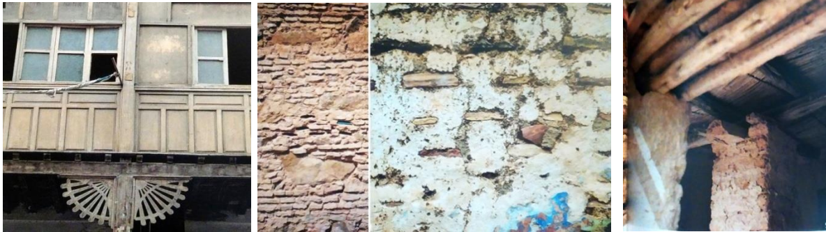
صورة (١٩) بور سعيد بمصر اعمال الاطر الخشبية تغطي مساحة واسعة من الواجهة والفتحات المعمارية.
