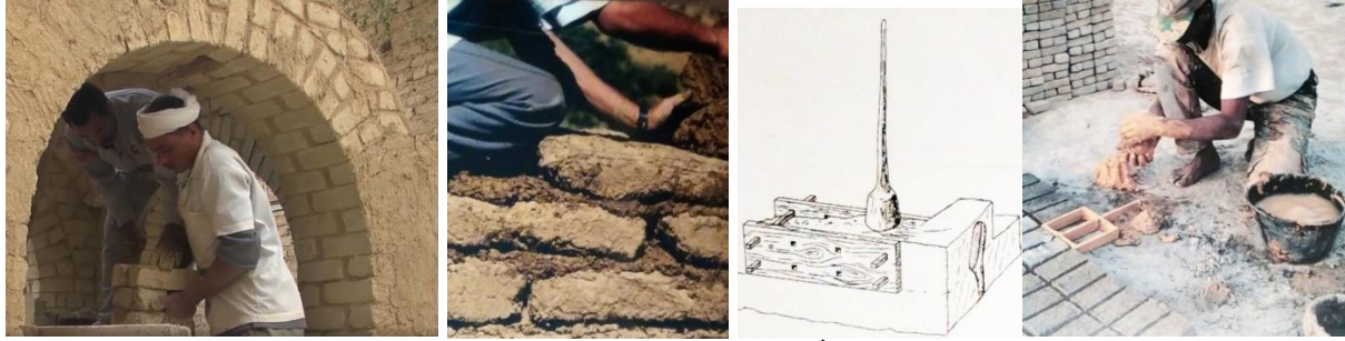
صورة (١١ و١٢) بلدة Hauf-Rif بالمغرب – تنفيذ من الطوب اللبن mud brick مثبت بمونة الملاط mortal حيث الحوائط الطينية mud wall المنتظمة والغير منتظمة – الطين مستخدم في صنع الوحدات البنائية هو نفسه المستخدم في صنع المونة مما يحقق تجانس العمل.
