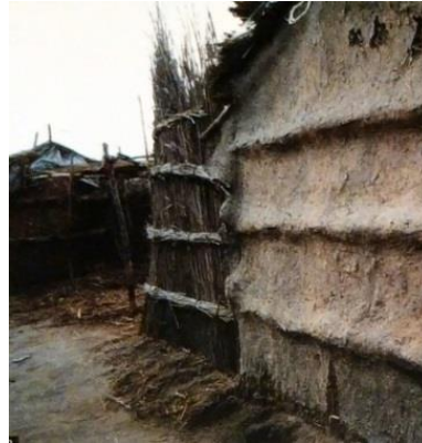
صورة (٥) Al Burg بمصر الخامات انتجت التقنيات حيث استخدام سعف النخيل فى البناء.
