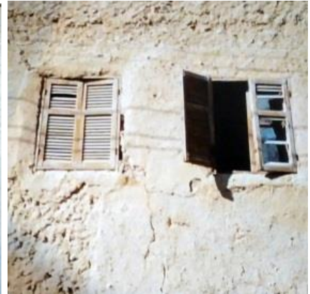
صورة (٢٣) واحة سيوة بمصر - هناك ملابس مختلفة للطلاء بـ earth rendering من الناعم اللطيف الى الخشن.
