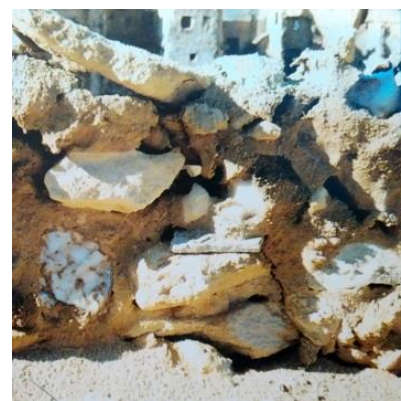
صورة (٤) واحة سيوة بمصر - بناء من حجر الملح salt stone يسمى kershif يتم تثبيته بملاط الارض earth mortar .
