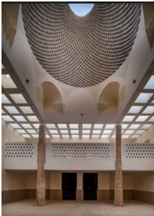
صورة رقم (11،12،13) مسجد باصونة ، أسيوط، جمهورية مصر العربية، وليد عرفة(للفراغ الداخلي للمسجد) توضح ان القبة بنيت بطريقة بها بروز منتظمة من الداخل والخارج، في محاولة للتفرد التقني وربط شكل التصميم الخارجي والداخلي كوحدة واحدة.
