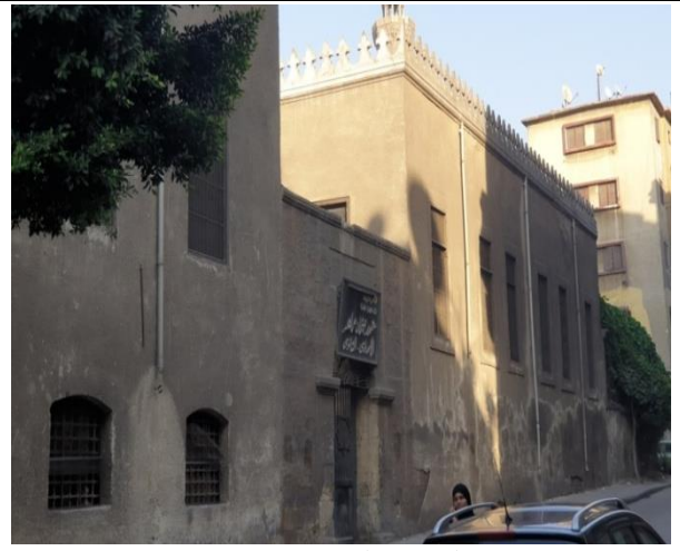
شكل رقم (9) الواجهة الرئيسية وتوضح عدد النوافذ التي على يمين المدخل (تصوير الباحثة).
