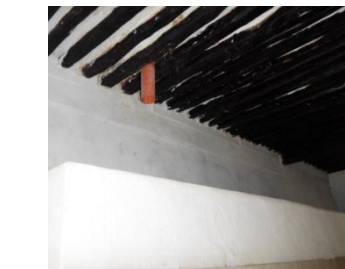
لوحة(19)ميازيب لتصريف المياه لخزان الماء
