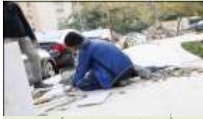
شكل (١٩) أعمال صيانة الأرصفة
