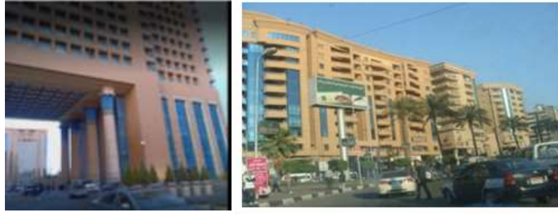
شكل ( ٣٤ ) يوضح منظور المعالجات التقنية المستخدمة في واجهات المباني الخارجية
