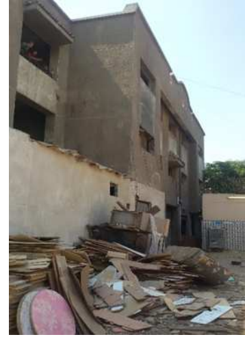
شكل (٢٣) : بناء مخزن خلف المركز
