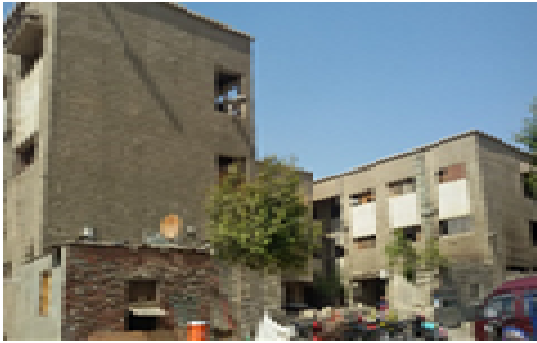
شكل (٢٧) : بناء غرفة عشوائية أمام المركز لإدارة جراج التوك توك
