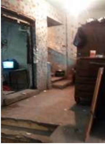
شكل (٢٥) : بناء ورشة أسفل قنبة السلم
