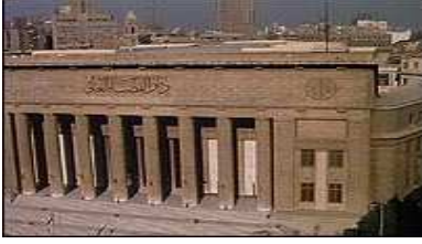
شكل (١٠): دار القضاء العالي مبنى ذو سلطة قضائية.
