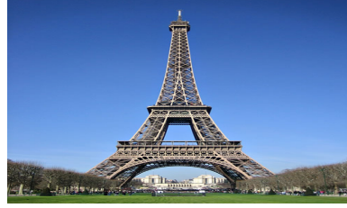
شكل (١٢): برج إيفل المتميز إنشائياً لانه اول مبنى بالحديد المكشوف ١٨٨٧.
