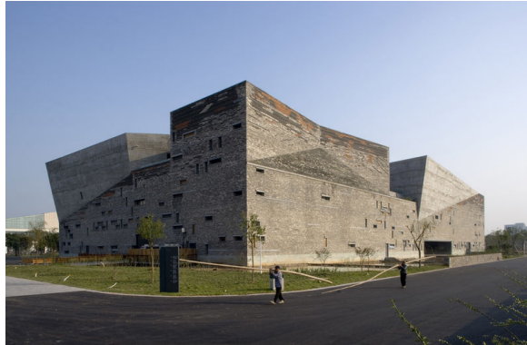
شكل (٤) متحف نينغبو للتاريخ بالصين إن واجهة المبنى مصنوعة من حطام القرى التي دمرت عندما اختارت الحكومة بناء مشاريع جديدة في المنطقة المحيطة
