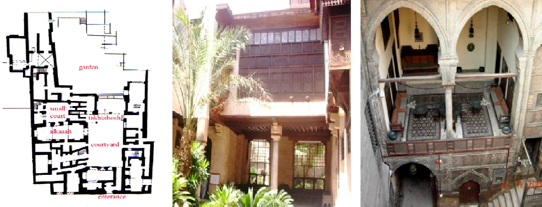
شكل (١٢) المقعد المطل على الفناء والحرمك بمشربياته والتختبوش والمدخل المنكسر لتحقيق الخصوصية.
