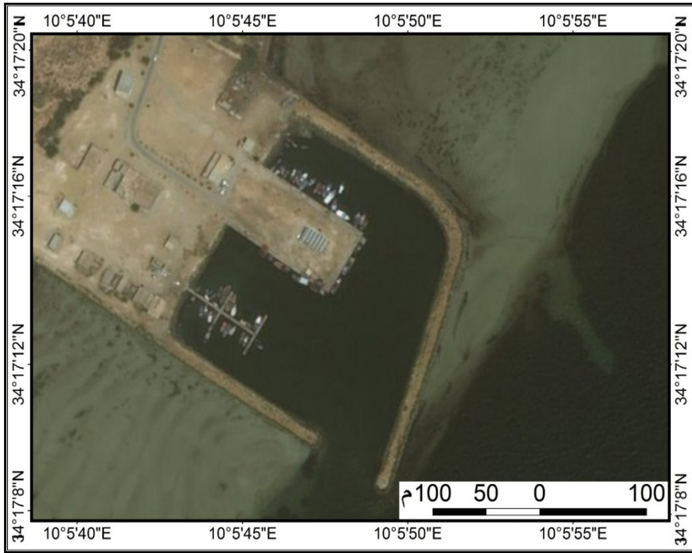
المصدر: Service Layer Credits صور (٧) صورة جوية لميناء الصخيرة
