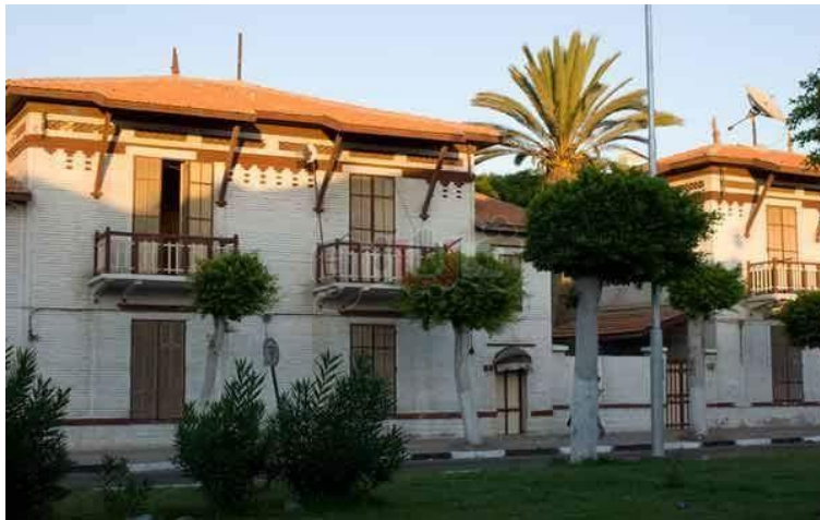
صورة رقم (1) منطقة الفلل جنوب ورش شركة القناه بمدينة بورفؤاد عام 2017
