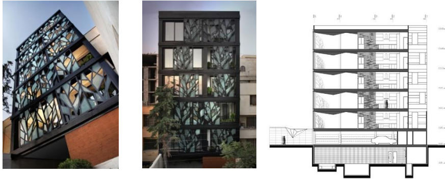
شكل (3) واجهة خارجية توضح التشكيل للواجهة بمعالجات الستائر المظلمة الخارجية المنزقة و المستوحاة من الطبيعة و مستخدم بها خامة المعدن و الزجاج المعالج للفتحات المعمارية.
