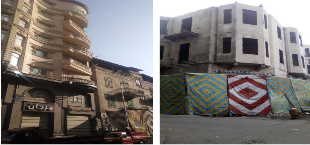
صورة رقم ( ١٠ ) توضح حالات المباني بالقلب التجاري بمدينة دمياط المصدر/ الدراسة الميدانية لمنطقة الدراسة, ( قلب دمياط التجاري) يناير ومارس ٢٠٢٠.
