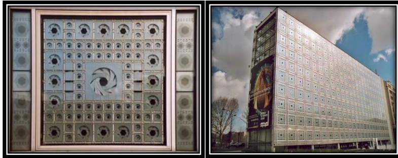
شكل رقم (٢) المشربيات بالواجهة واتساع حركة المشربية عند الحاجة لضوء الشمس وإغلاق فتحاتها عند زيادة كمية الضوء بمبنى معهد العالم العربي بباريس
