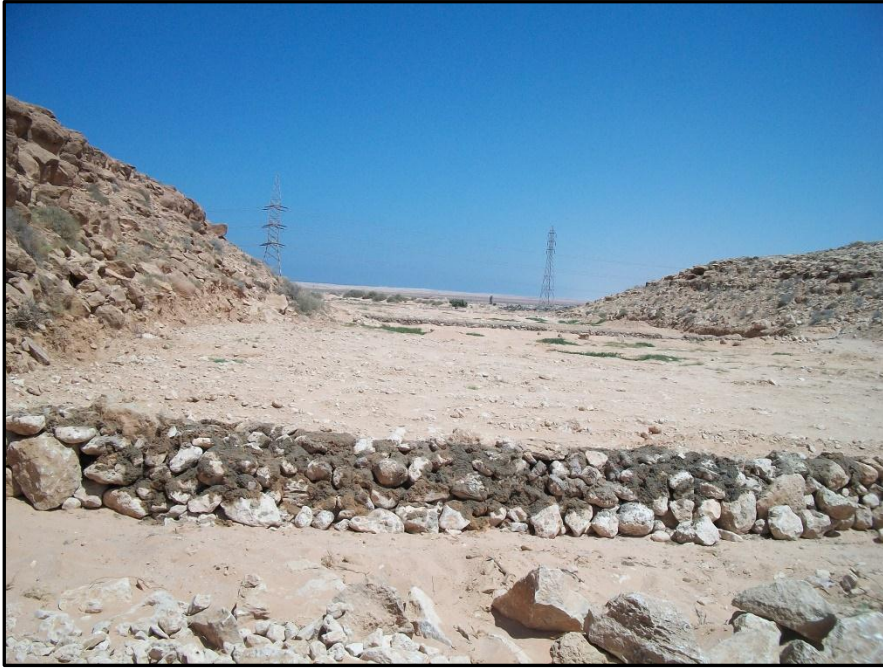
صورة ( ١٥ ) توضح بعض السدود الحجرية بين الأحواض الزراعية كأحد وسائل تقليل خطر السيول على الأراضي الزراعية - وادى الخير
