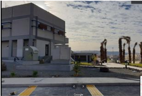
شكل رقم (٤٨): يوضح أماكن مواقف السيارات وعربيات ذوي الاحتياجات الخاصة محاطة بكامل المسجد بالخارج - تصوير الباحثة
