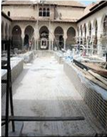
(لوحة ١٤) أعمال الترميم بقصر المشور عن: Arcade Tlemcen
