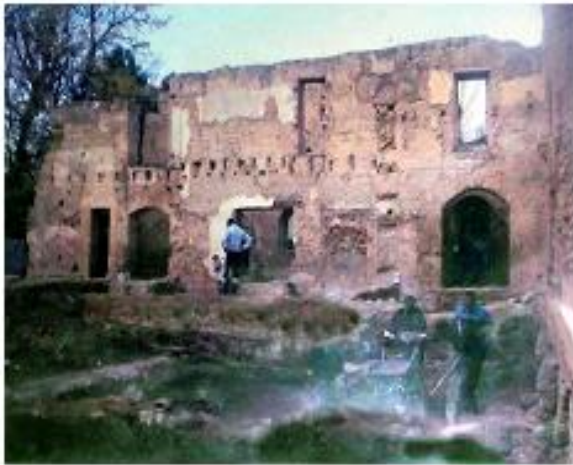
(لوحة ١٠) أعمال الحفائر بقصر المشور عن: Arcade Tlemcen
