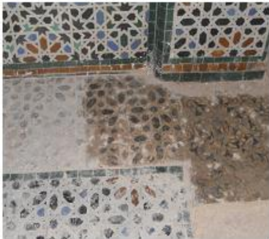
(لوحة ١٦) تحديد بقايا الزليج الأصلية بقصر المشور تصوير الباحث
