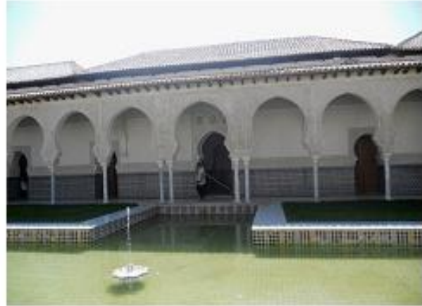
(لوحة ٣١) الواجهة الجنوبية لجناح الراحة الشمالي تصوير الباحث
