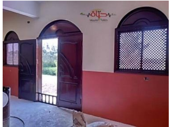
فريق حياة والأهالى أثناء بناء المسجد وتأسيسه
