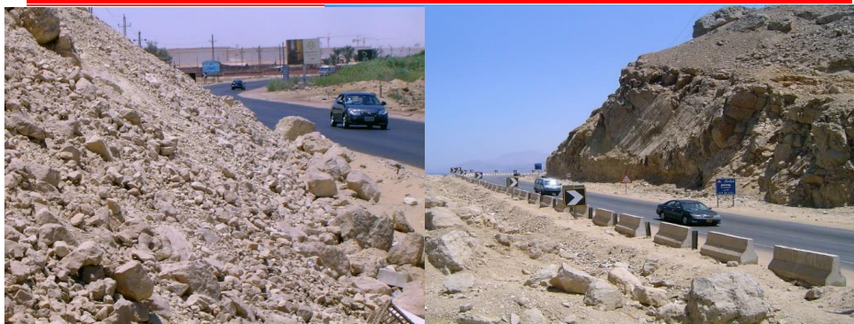
المصدر: الدراسة الميدانية ٢٠١٧/٠٩/١٥ م صورة (٥) الكتل الصخرية المتساقطة بجانب الطريق
