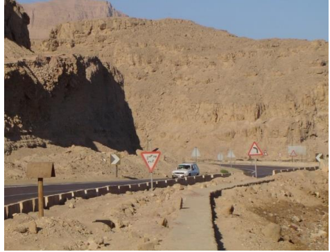
صورة (٢) تعرجات الطريق والحافات الجبلية الرأسية المصدر: الدراسة الميدانية ١٥/٠٩/٢٠١٧م
