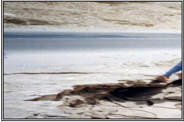
تآكل جوانب طريق ادفو/ مرسى علم بسبب مرور السيول بجوار الطريق
