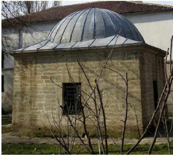
لوحة (١١) الواجهة الشمالية
