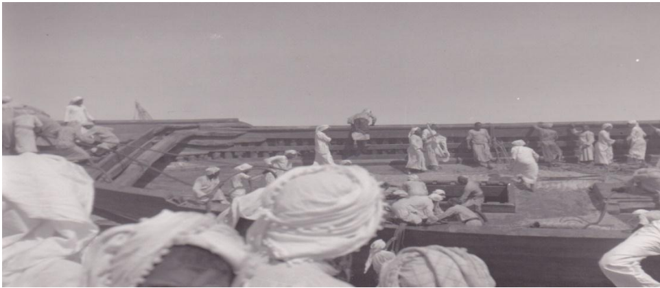
8. صورة لنفس السفينة من زاوية السطح وبدى في الصورة بعض البحارنة (القاليف) يقومون بعملهم لإكمال بناء السفينة (١٩٣٧-١٩٣٨م)
