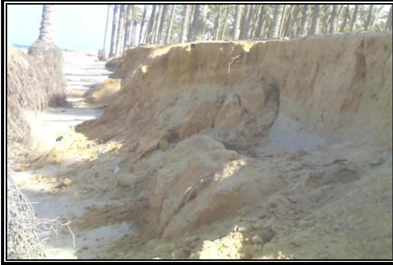
صورة (١) انهيار الرواسب نتيجة قنوات المد عند أقدام الجروف
