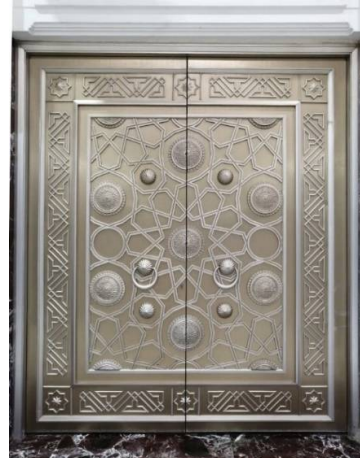
شكل (1) يوضح باب مزخرف بمواسير ذات قطاعات مستطيلة ومصممة من الـ AI سمك 10مم ومشغلة بالقطع بتقنية الووتر جيت بمسعى الصفا والمروة بالمسجد الحرام بمكة المكرمة.
