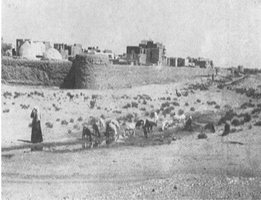
البرج الجنوبي الشرقي وسور الطائف (الجميع هدم) في الخمسينات من القرن الرابع عشر الهجري من كتاب الطائف القديم، عيسى القصير
