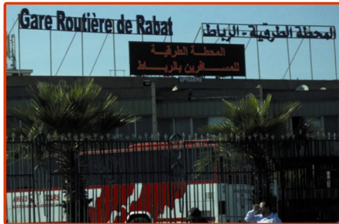
صورة (٤) : المحطة الطرقيّة - بين مقاطعتي أكادال الرياض ويعقوب.
