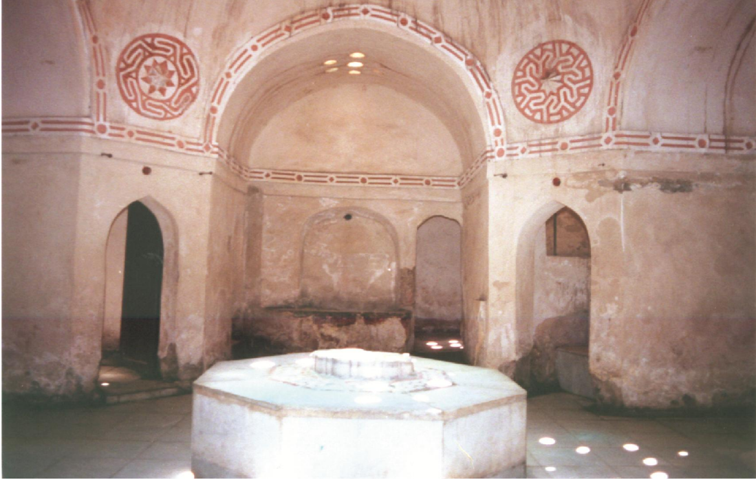
لوحة رقم (٢) منظر عام لبيت الحرارة بحمام عزوز بمدينة رشيد، ويظهر به القاعة المثلثة وبوسطها نافورة الماء الساخن وحولها مسطبة التكييس، ويخرج منها أحد الأواوين وأبواب الخلاوي والمغطس، عمل الباحث
