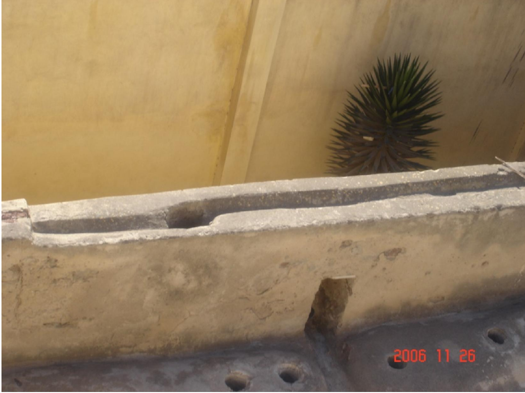
لوحة رقم (١٠) توضح قناة الماء التي تعلو سور سطح الحمام، من عمل الباحث
