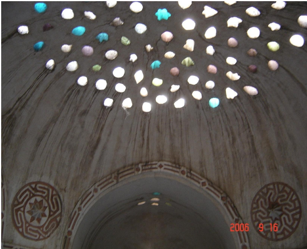
لوحة رقم (٣) القبة الرئيسة ببيت حرارة حمام عزوز بمدينة رشيد ويظهر بها المضاي، عمل الباحث
