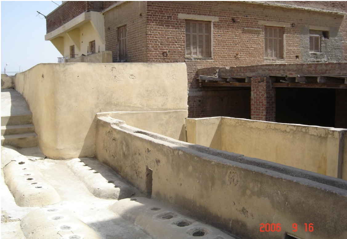
لوحة رقم (٩) توضح حاصل المياه بحمام عزوز وخروج قناة المياه منه، من عمل الباحث
