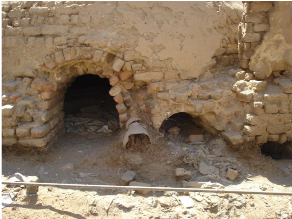
لوحة رقم (٢١) فتحة تزويد الدسوت بالمياه بحمام علي بيك بجرجا، من عمل الباحث
