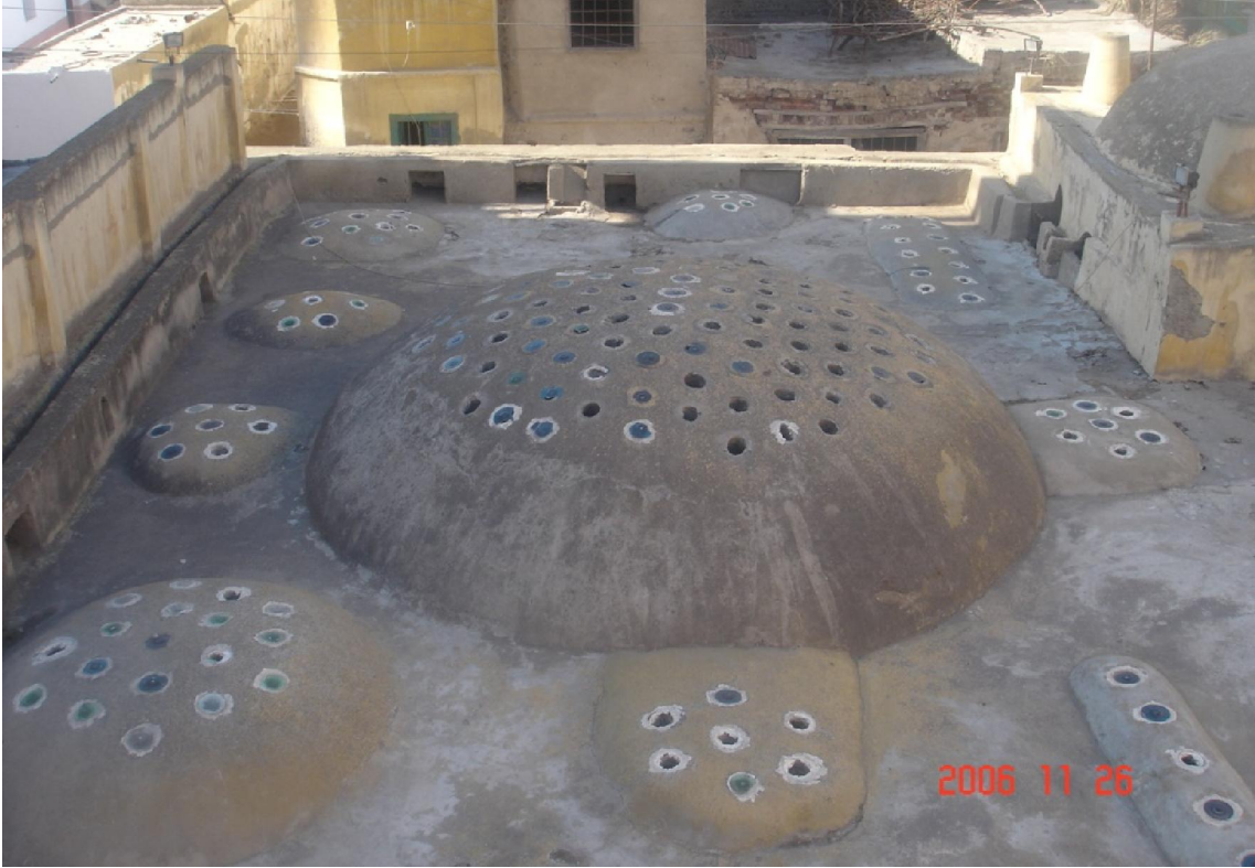
لوحة رقم (٨) توضح سطح منطقة بيت الحرارة بحمام عزوز ويظهر قناة المياه التي تنقل بين الحاصل والدبكونية أعلى السور المحيط، من عمل الباحث
