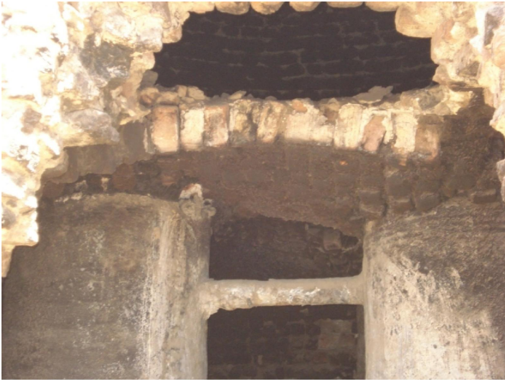
لوحة رقم (١٧) وتوضح الدسوت داخل الدبكونية، ويظهر أعلى الدسوت قبة ضحلة يعلوها القبة الرئيسية للمستوقد، من عمل الباحث
