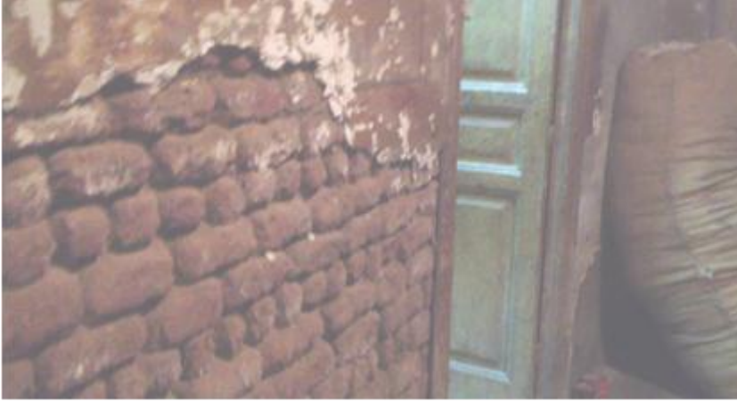
(لوحة ٣) طريقة وضع المداميك فى البناء بالطابق الأرضى
