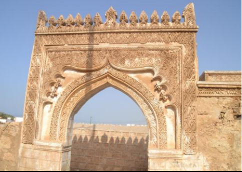
(لوحة رقم ٣) العقد المدبب الذي يتوج المدخل الرئيسي بالواجهة (تصوير الباحثة ).
