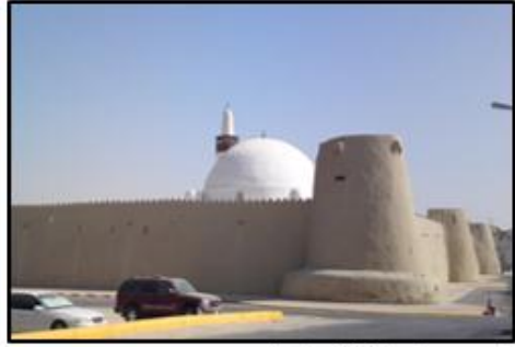
المصدر الدراسة الميدانية. صورة (٤): بناء الحوائط والأبراج من الطين والطفل بقصر ابراهيم فبراير عام ٢٠٢٠م
