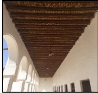
المصدر: الدراسة الميدانية. صورة (٦): بناء الأسقف من جذوع النخيل والدنكل في قصر إبراهيم فبراير عام ٢٠٢٠ م
